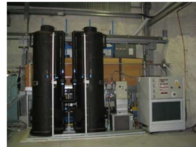
Pohled na část antiradonového filtračního zařízení (chladič systém, zásobníky aktivního uhlí) vyrobeného firmou ATEKO, Hradec Králové pro francouzskou podzemní laboratoř Fréjus.
